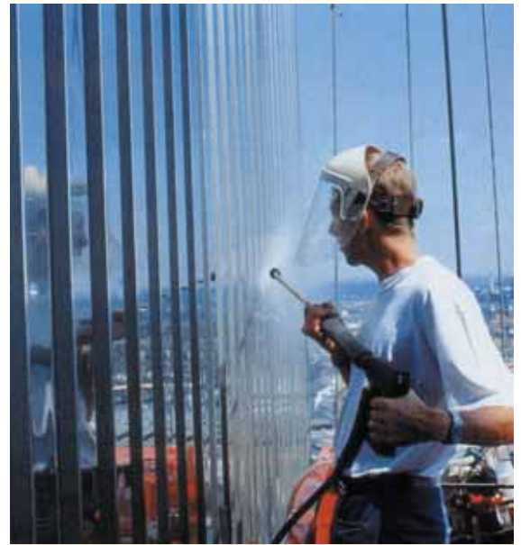
Unterhaltsreinigung einer Edelstahl-Rostfrei-Fassade nach nahezu 40 Jahren in Großstadt-atmosphäre (Foto: Informationsstelle Edel-stahl Rostfrei). (g03711/1)
